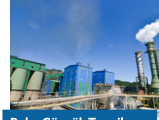
Bolu, Göynük Termik Enerji Santrali
