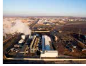
Şanlıurfa Akaryakıt Santrali
