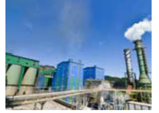
Bolu, Göynük Termik Enerji Santrali
